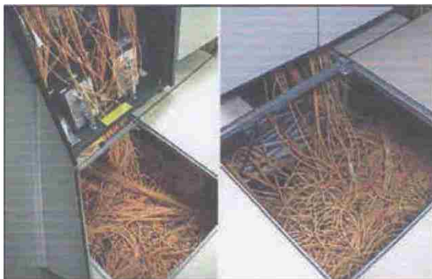
شکل ۵-۲- نمونه‌ای از کابل‌کشی نقطه به نقطه
